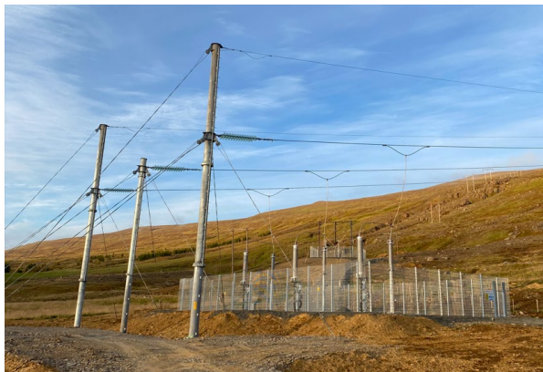
Mynd 25. Strengendavirki í 220 kV Hólasandslínu 3.
