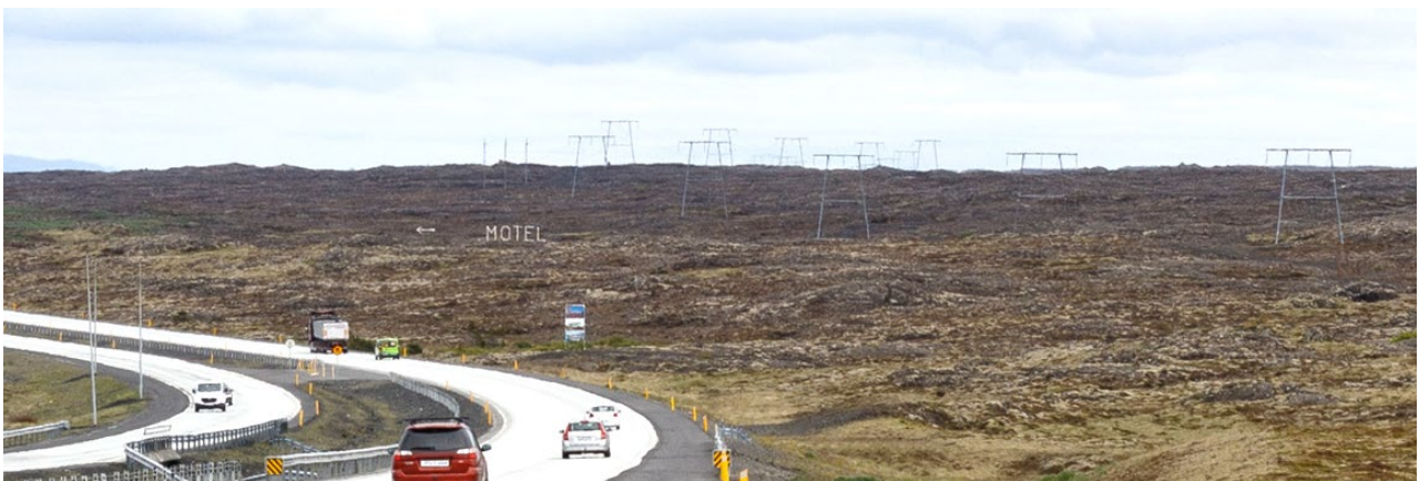
Mynd 32. Ljósmynd af aðstæðum við Vogu. Hér sést nokkuð greinilega að vegurinn liggur lægra í landinu en línurnar.
