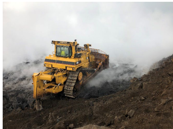
Mynd 20. Unnið við færslu á leiðigarði út á nýtt hraun við Stórhól 19.06.2021.
