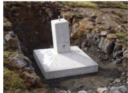
Mynd 4. Forsteypt undirstaða masturs.
