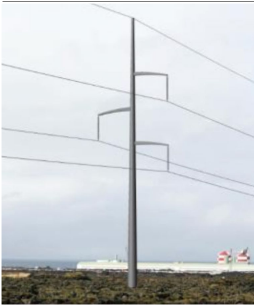
Mynd 22. Til vinstri er röramastur sem er fyrirhugað í SN2 í Hafnarfirði. Til hægri er hugmynd að röramastri á upphækkaðri fyllingu. Jarðvegsfylling umhverfis mastrið yrði útfærð þannig að hægt væri að hækka hana ennþá meira komi til raunverulegs atburðar. Með þessu móti má verjast allt að 8 m þykku hraunrennsli.
