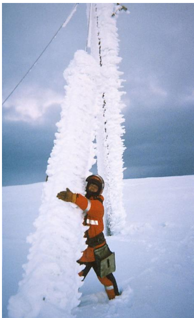
Mynd 1: Dæmi um skýjaísingu og mikil snjóþyngsli þar sem aðstæður til línulagna eru erfiðar.
