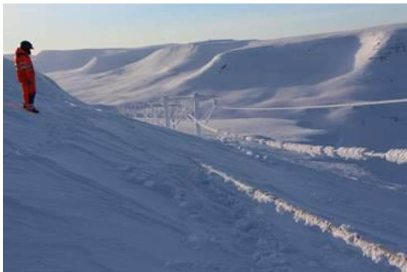
Mynd 1: Dæmi um skýjaísingu og mikil snjóþyngsli þar sem aðstæður til línulagna eru erfiðar.
