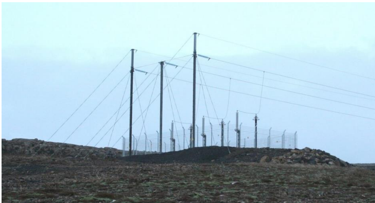
Mynd 6.8. Endavirki fyrir 132 kV jarðstreng (eitt strengjasett) í Hnoðraholtslínu 1. Efst eru jarðvírar til að verjast eldingum. Endavirkin í Hólasandslínu 3 þyrftu að vera talsvert umfangsmeiri, þar sem um er að ræða 220 kV jarðstreng.
