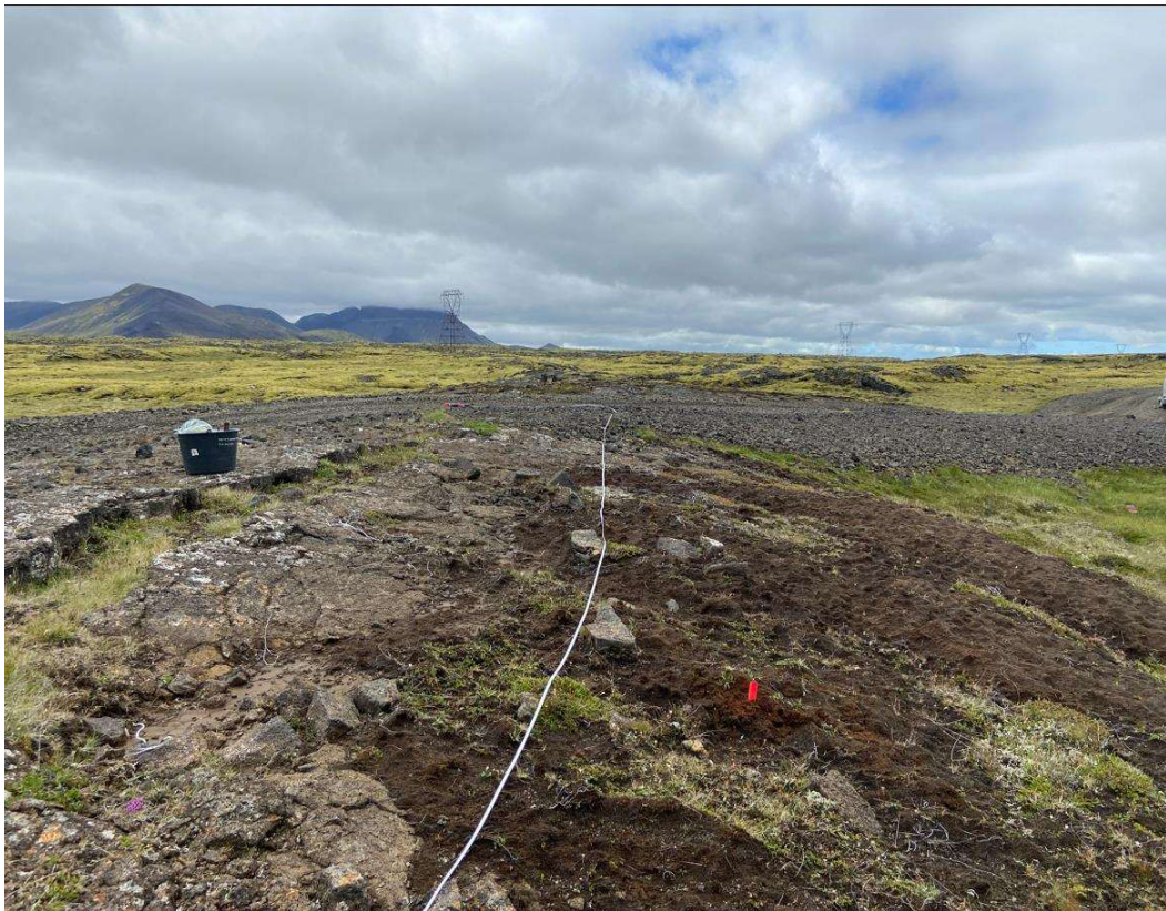
Mynd 4 Umfang gróðurskemmda áætlað með málbandi við mastur K5 við Kolviðarhól.
