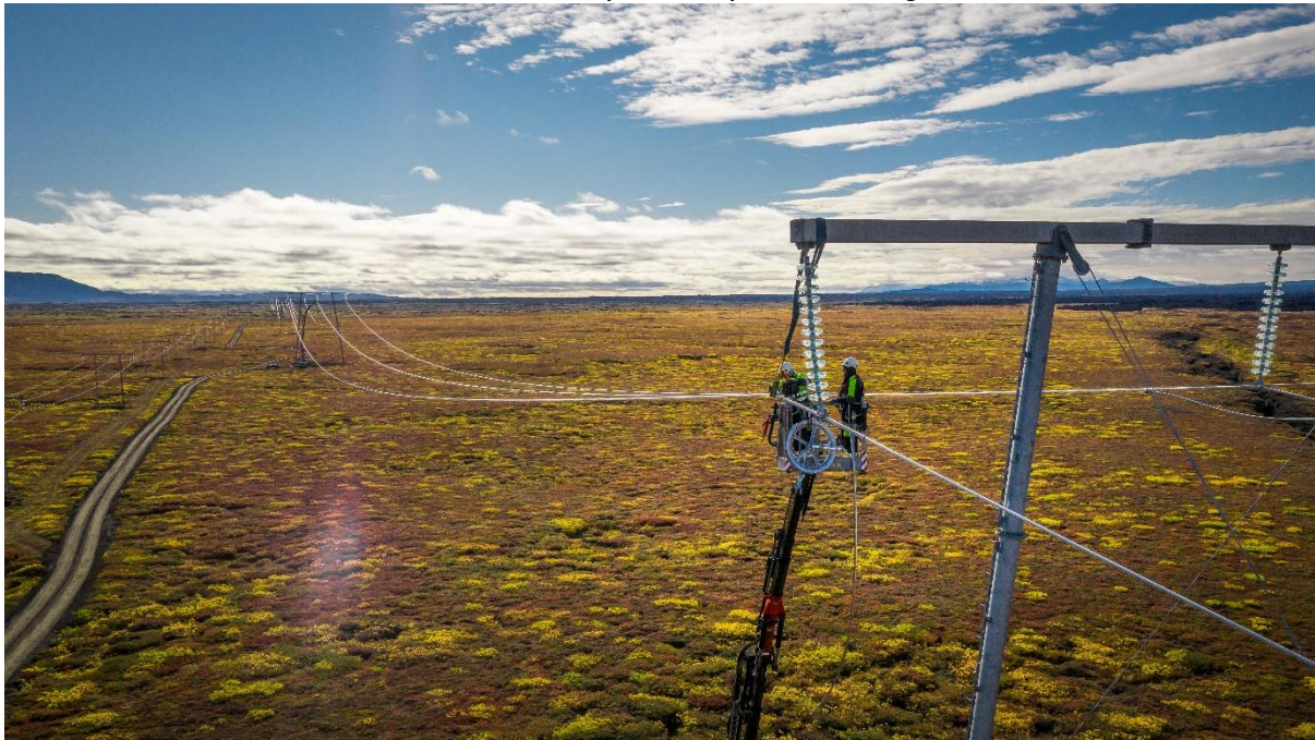
MYND 3-1 : TVÆR KYNSLÓÐIR BYGGÐALÍNU, KRÖFLULÍNA 2 OG KRÖFLULÍNA 3 Í STRENGINGU.
