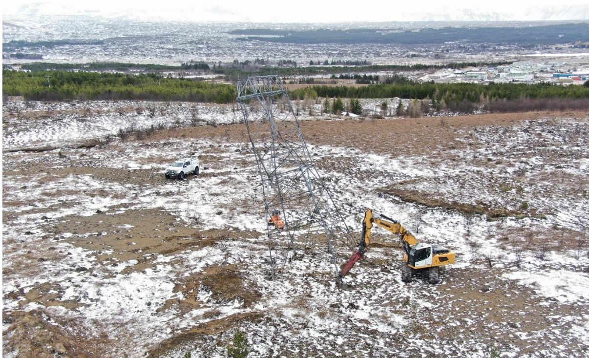
MYND 4-6: NIÐURRIF GÖMLU RAUÐAVATNSLÍNU 1 Á HÓLMSHEIÐI.
