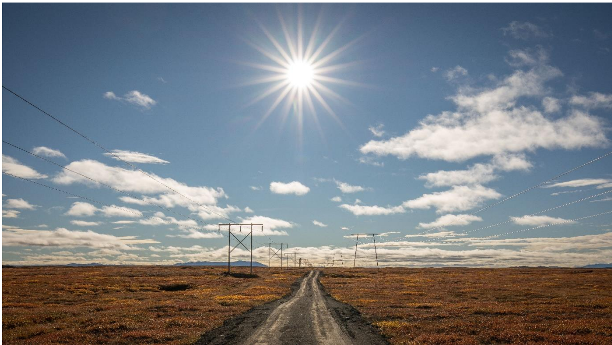
Mynd 6.19 Slóð við Kröflulínu 3. Á myndinni sést núverandi 132 kV loftlína vinstra megin á myndinni þar sem lögð hefur verið slóð samsíða og nýja 220 kV Kröflulínu 3 hægra megin við slóðina.
