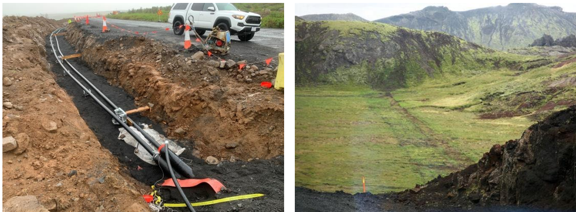
Mynd 6.18 Til vinstri er dæmi um umfang á lagningu 132 kV strengs, eitt sett við Korpulínu í Reykjavík sem var sett í streng 2020. Til hægri má sjá frágang eftir lagningu 132 kV Nesjavallastrengs 2, við Hengilssvæði, sumarið eftir framkvæmdir.
