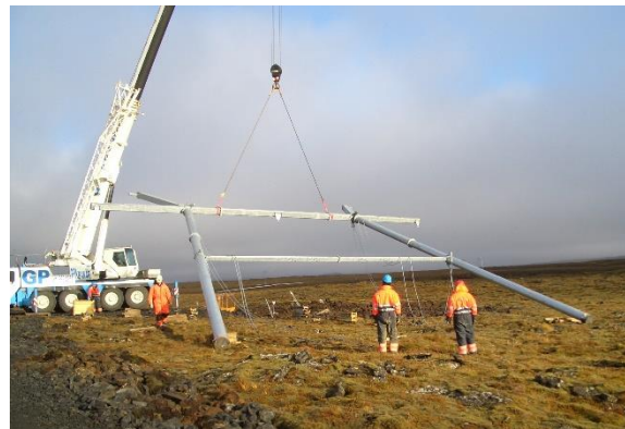
Mynd 6.7 Myndir sýna vinnu við samsetningu og reisingu stagaðs burðarmasturs af M-gerð með jarðvírseyrum. Myndirnar eru frá byggingu Reykjaneslínu 1.
