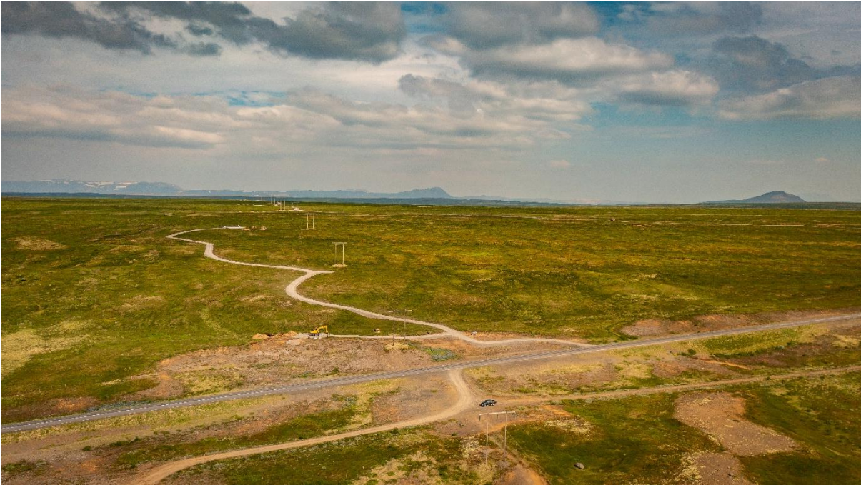
Mynd 6.21 Vegslóð sem hefur verið lögð á landi og aðstæðum við byggingu Hólasandslínu 3 samhliða Kröflulínu 1.
