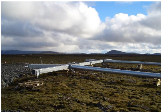
Mynd 6.7 Myndir sýna vinnu við samsetningu og reisingu stagaðs burðarmasturs af M-gerð með jarðvírseyrum. Myndirnar eru frá byggingu Reykjaneslínu 1.
