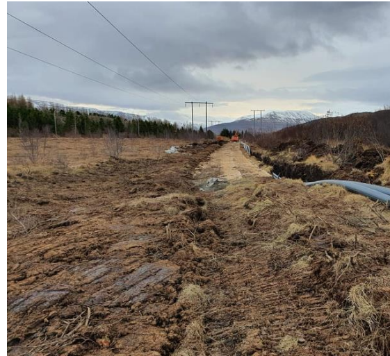
Mynd 6.13 Útdráttur strengs (Hólasandslína 3 á Akureyri). Uppi til vinstri er strengkefli á útdrattarplani og útdráttur í gangi. Uppi til hægri eru allar þrjár leiðararnir komnir í skurðinn og byrjað að sanda yfir. Niðri til vinstri er byrjað að leggja varnarborða yfir sandinn. Niðri til hægri er búið að loka yfir vinstri skurðinn en verið er að leggja ídráttarrör fyrir strenginn í hægri skurðinn.
