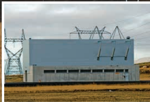
Nýtt tengivirki Landsnets á Kolviðarhóli.
