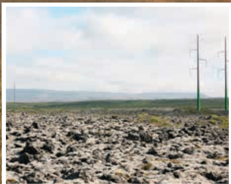
Mastur af þessari gerð gæti komið til álíta þar sem línugata er þröng.
