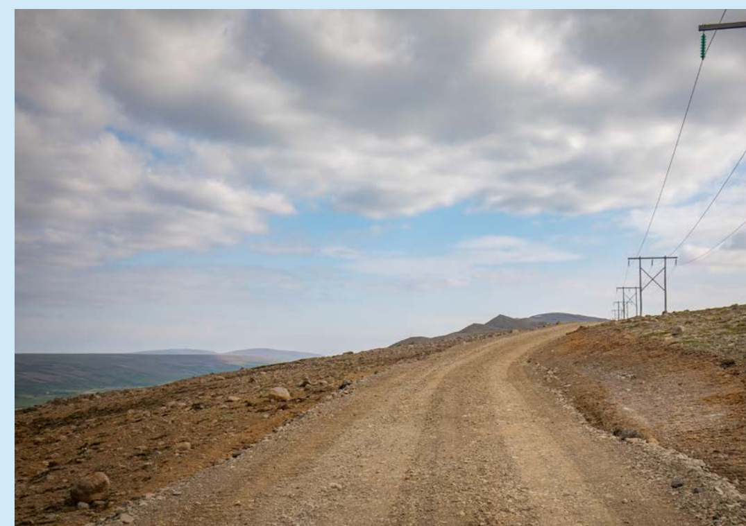
Dæmi 4. Nýleg línuslóð vegna Hólasandslínu 3
