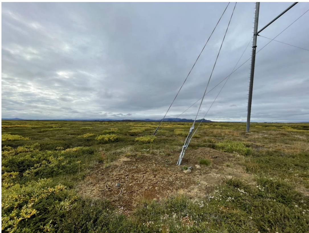
Mynd 3.5 Stálörámastur og stög KR3 sunann Þjóðveggar 1 við Nýjahraun. Ennþá sést í sár eftir framkvæmdarask en gróður farinn að taka vaxa í sárinu. Framkvæmdum lauk 2022.
