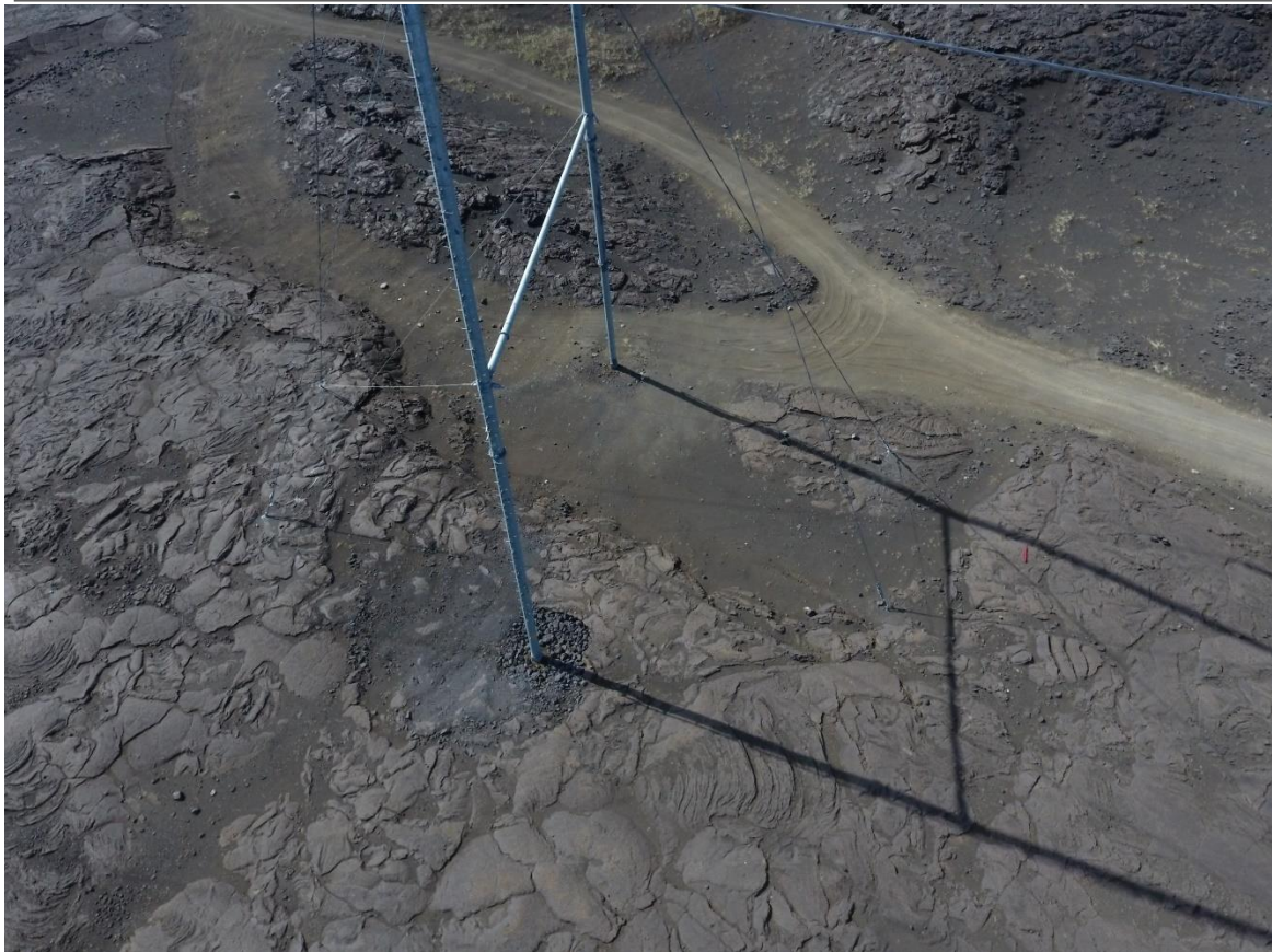
Mynd 3.6 Stálröramastur og stög KR 3 á hrauni. Ummerki eru við möstur, en lítil sem engin ummerki sjást þar sem stög eru fest í jörðu með bergboltum.
