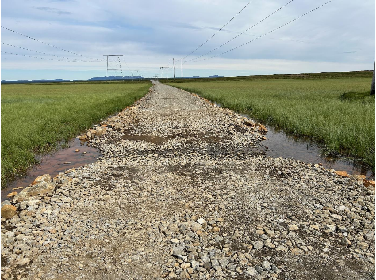
Mynd 7.9 Slóðagerð yfir votlendi við Hólasandslínu 3.
