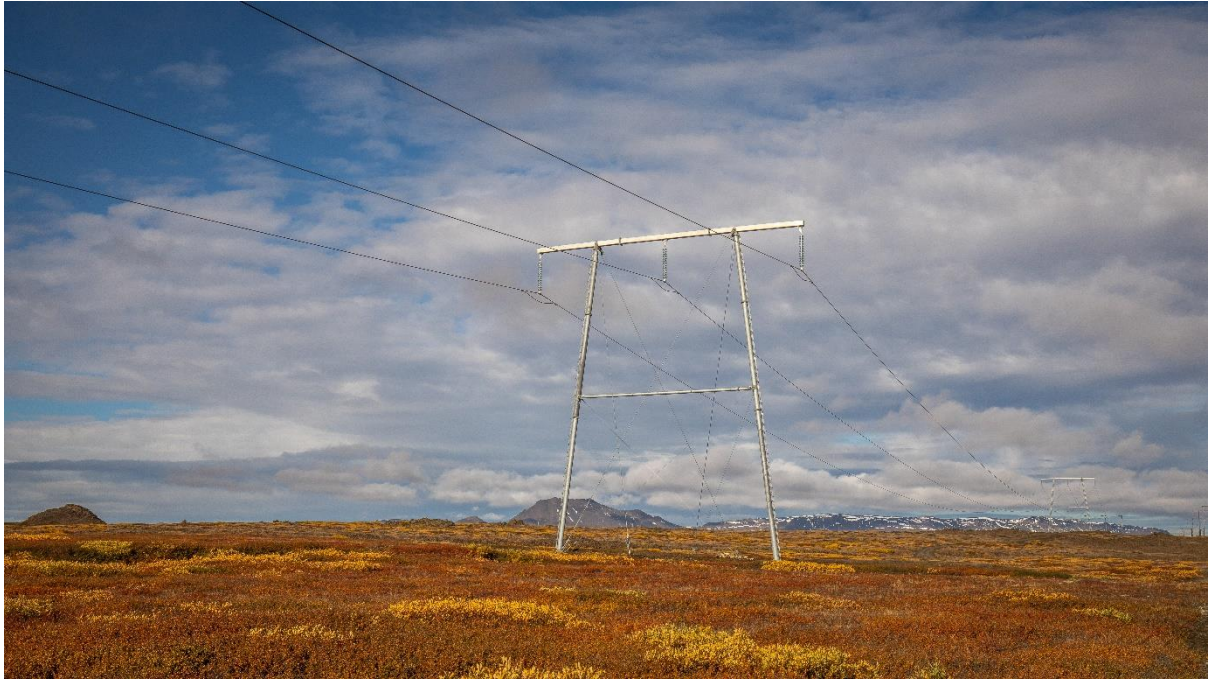
Mynd 7.2 Mastursgerð sem stefnt er að því að nota á stærstum hluta Holtavörðuheiðarlínu 1. Mynd sýnir mastur án jarðvíra.
